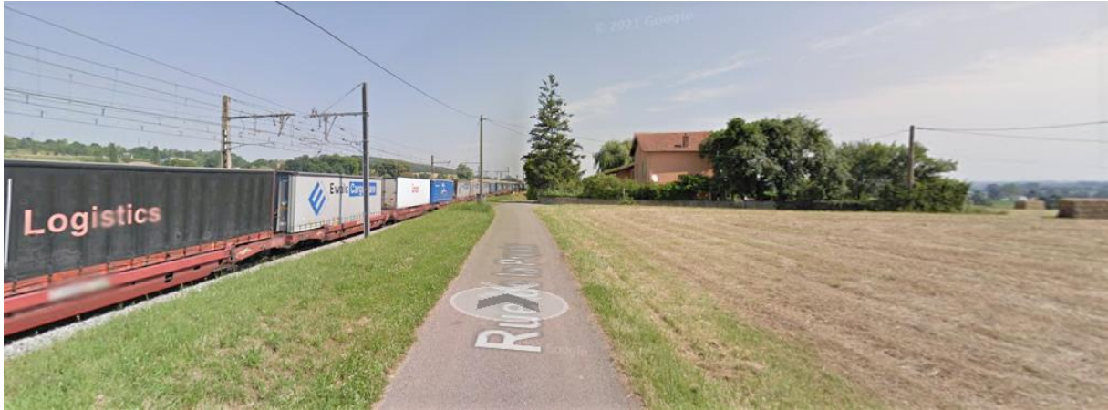
La maison Pardon, rue de la Preste (dir. Nord). Emplacement projeté de la passerelle - Google Streetview
