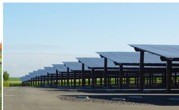
Exemple d'ombrières photovoltaïques - Wikimedia
